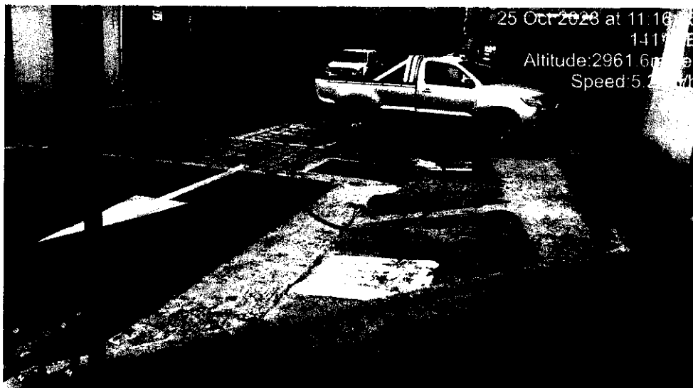
Figura 13. Antigua parada de buses, calle Gonzales Suarez, coordenadas: 0°30'47.2"S 78°34'01.2"W.
