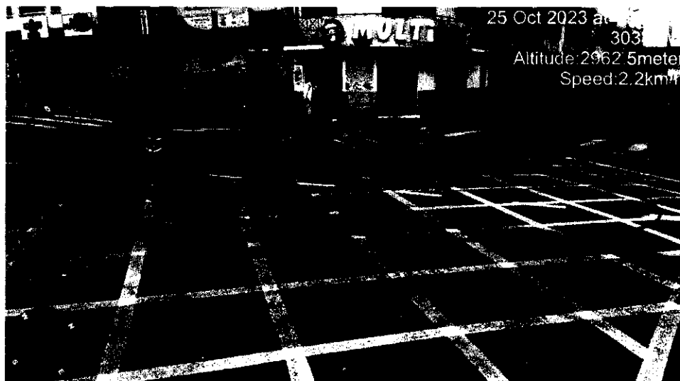
Figura 14. Líneas entre cortadas en medio de la vía, calle Gonzales Suarez, coordenadas: 0°30'46.9"S 78°34'01.4"W.
