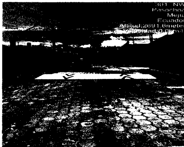
Figura 4. Ubicación del reductor de velocidad.
