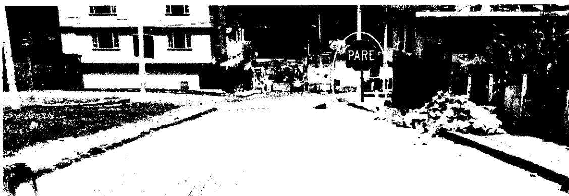
Ilustración 9.- Sitio de colocación señalética vertical preventiva, tramo 2, sentido Oeste – Este.
