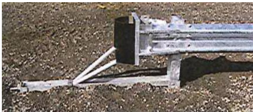
Imagen 1. Terminal atenuador para barrera lateral, Redireccionables–No traspasables (RNT).
