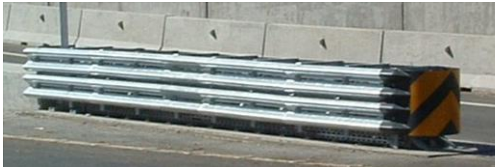
Imagen 2. Terminal atenuador o amortiguador de impacto para parterre, Redireccionables–No traspasables (RNT).
