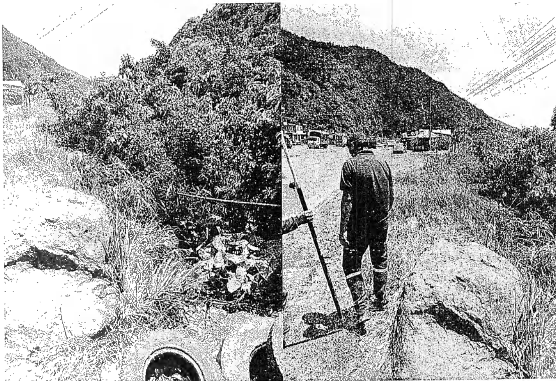
Figura 4. Cruces de aguas pluviales existentes.
