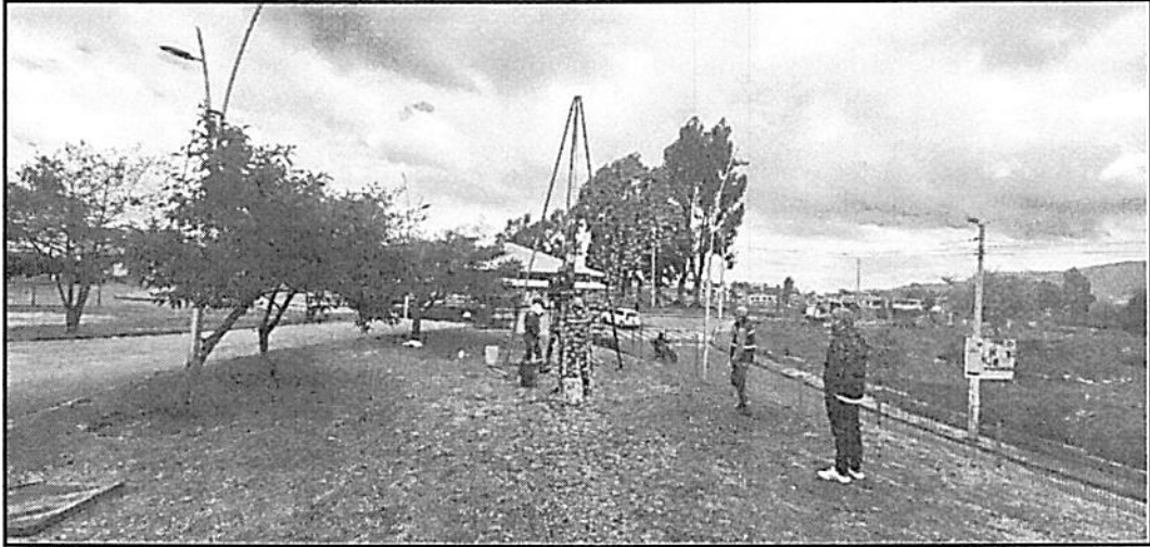
Sondeo 1 – Estribo Izquierdo
