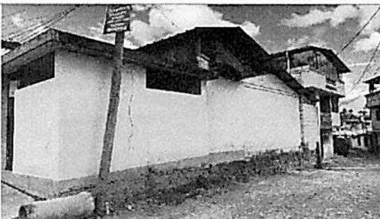
Fotografía 3: Vista completa hacia la fachada lateral de la casa barrial de El Murco.
