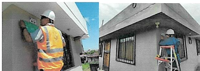
Imagen 18: Colocación de placas
