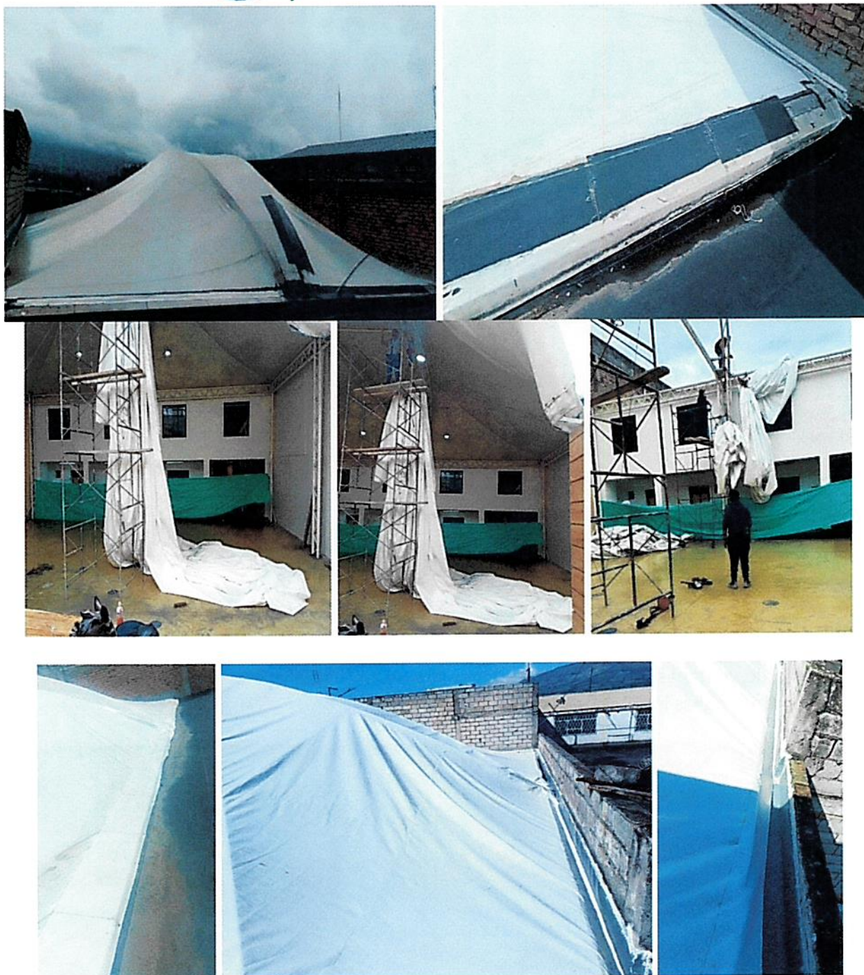
Colocación de cielo raso en el área de despacho vehicular.
