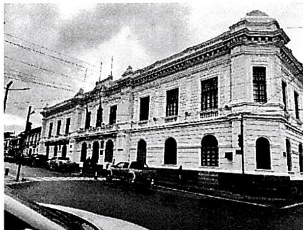
Fotografía N° 2 FACHADA PRINCIPAL CALLE JOSÉ MEJÍA
