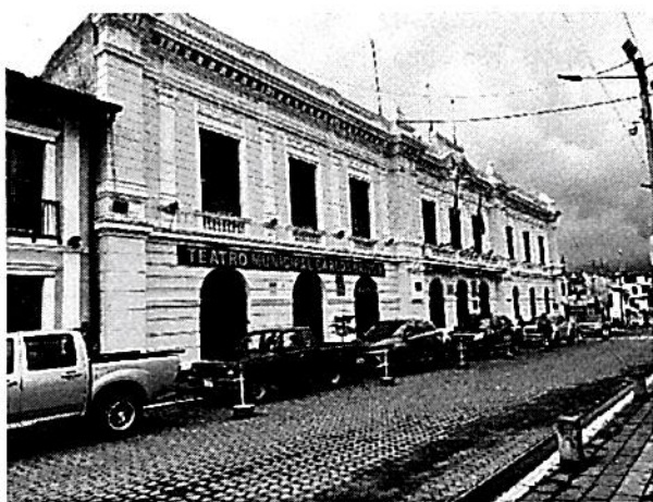
Fotografía N° 1 FACHADA PRINCIPAL CALLE JOSÉ MEJÍA
