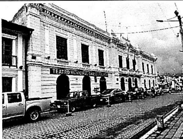
Fotografía N° 1 FACHADA PRINCIPAL CALLE JOSÉ MEJÍA
