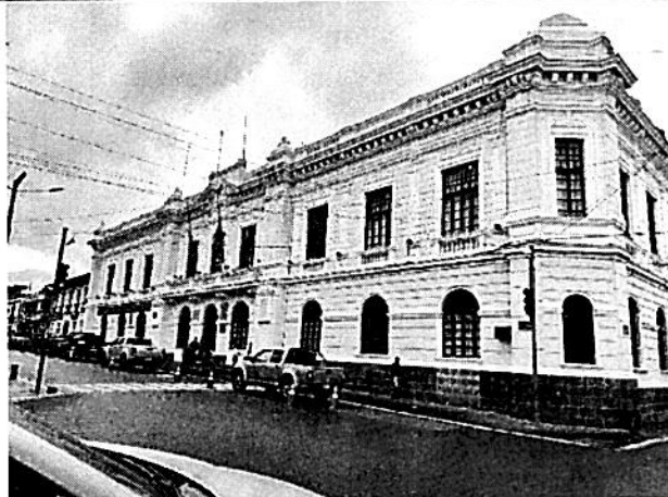
Fotografía N° 2 FACHADA PRINCIPAL CALLE JOSÉ MEJÍA
