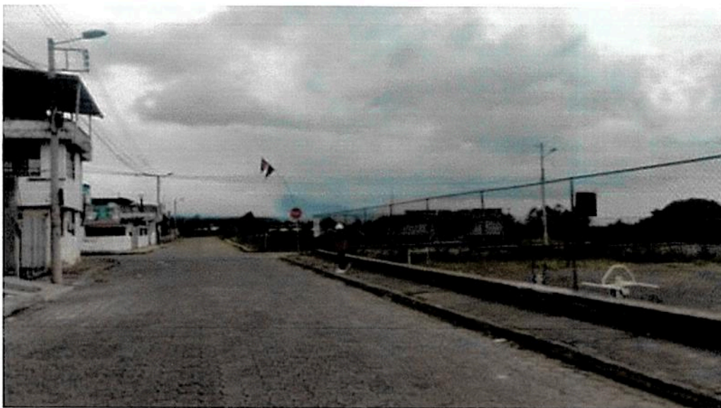
Fotografía 1: Inspección vial Comité Pro-mejoras del Barrio “La Cruz”.
