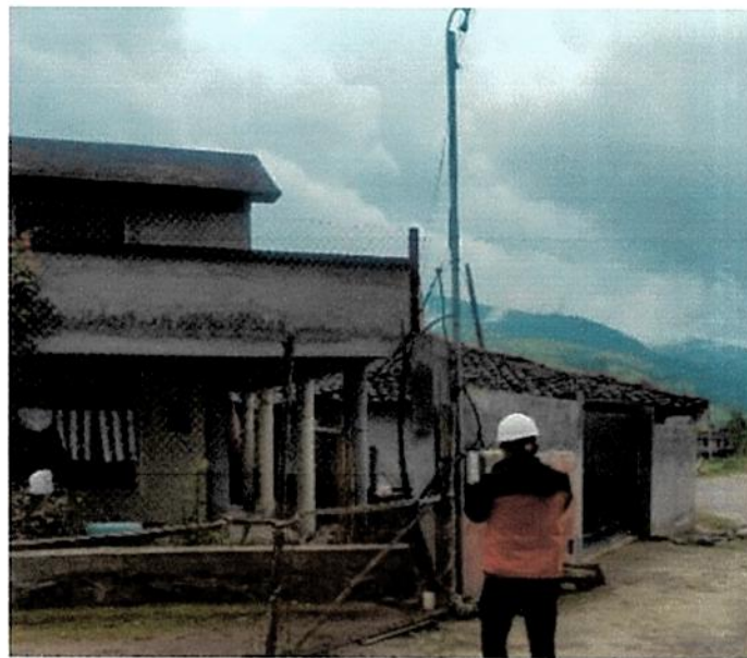
Fotografía 2: Inspección vial barrio “San Agustín”
