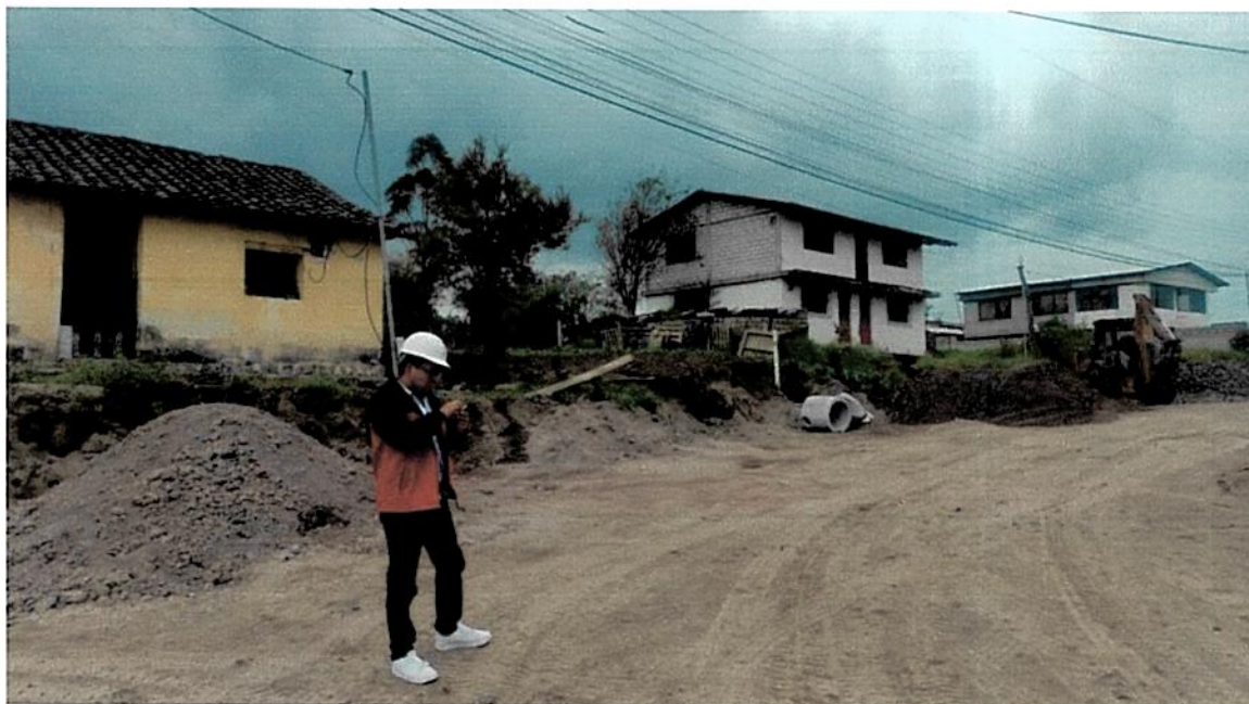
Fotografía 3: Inspección vial barrio “San Agustín”
