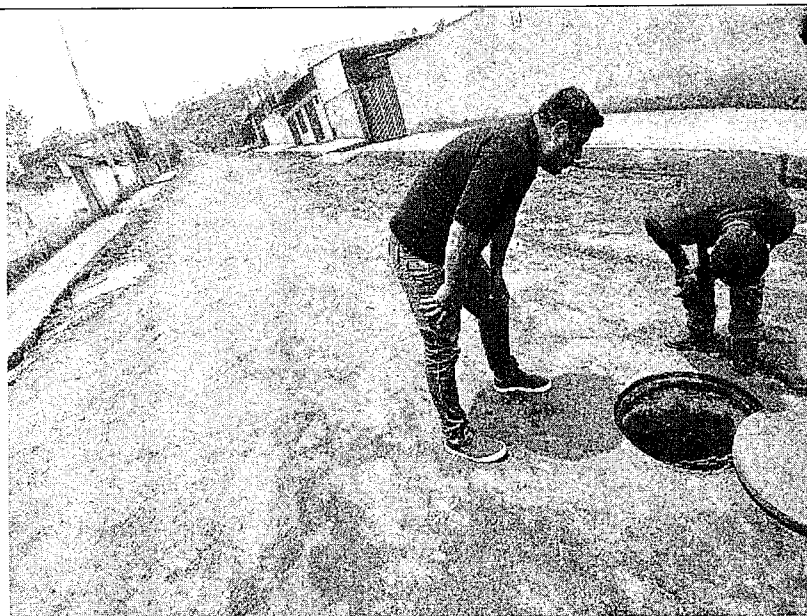
Pozo #1 Intersección Calle Machachi y Calle Tambillo
