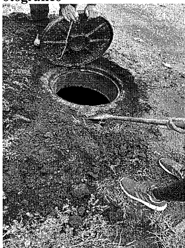
Figura 3. Pozo de revisión de alcantarillado
