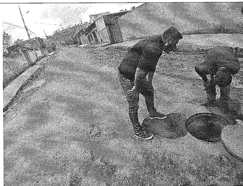
Pozo #1 Intersección Calle Machachi y Calle Tambillo
