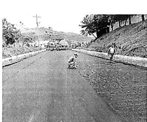
Colocación de Geomalla
