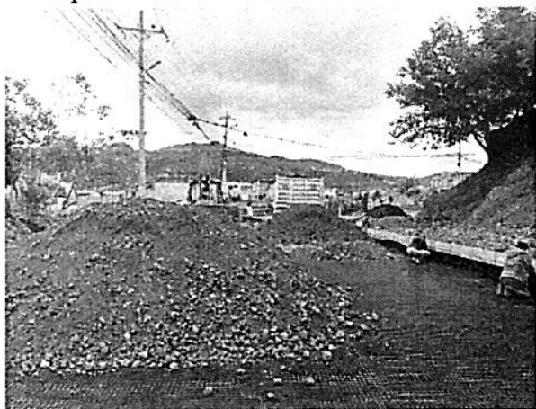
Transporte de subbase clase III
