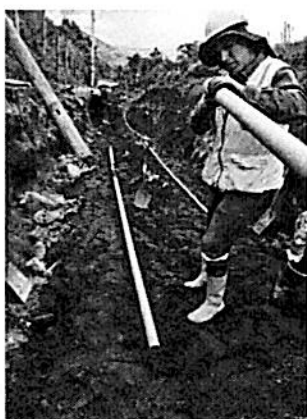
Figura 22. Instalación de la tubería de la red de distribución.
