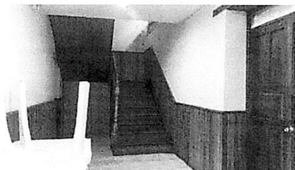
Fotografía N° 9 DUCTO DE GRADAS
