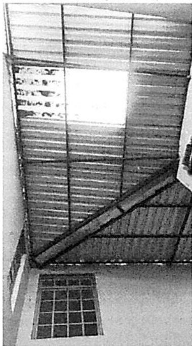
Fotografía N° 23 CUBIERTA PATIO INTERNO
