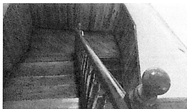
Fotografía N° 10 DUCTO DE GRADAS
