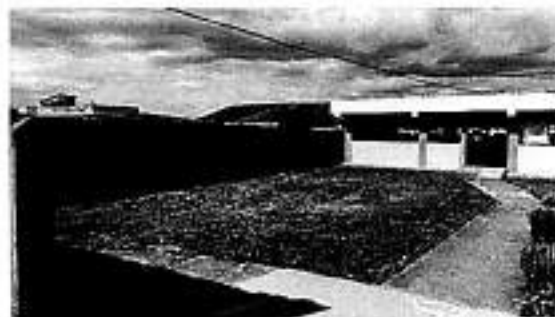
Fotografía N° 4 Espacio lindero Norte
