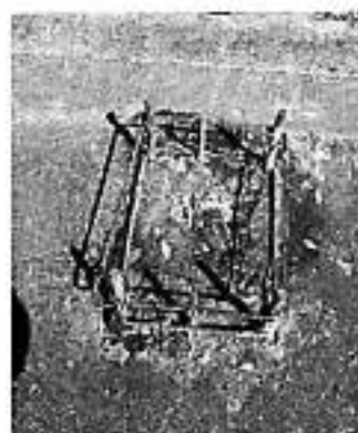
Fotografía N° 6 Armadura de columnas
