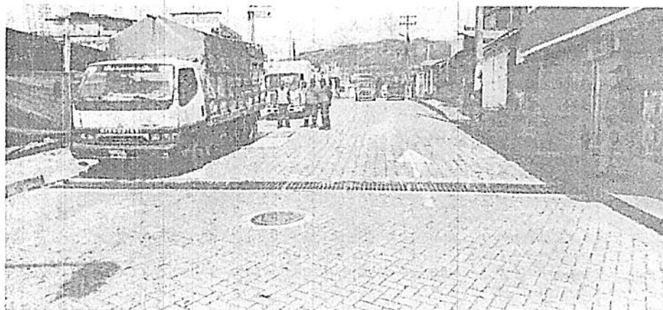
Imagen 4. Ubicación de sumidero transversal para la recolección de aguas lluvia.
