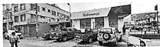
Tapas y rejillas de acceso a CT4 obstaculizadas.
