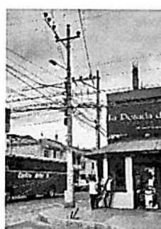
Redes sin retirar Pe26, sin Poste L80.
