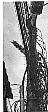
Pe36 Red MV y BV sin conexión.
