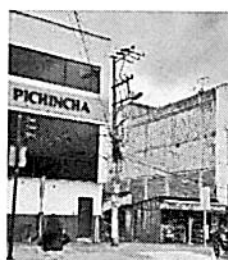
Redes MV Pe41 aéreas sin retirar.
