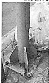
Tornillo en tapa sin ajuste L93.
