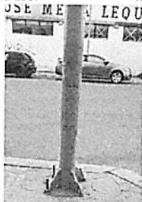
Tornillo en tapa sin ajuste L111.
