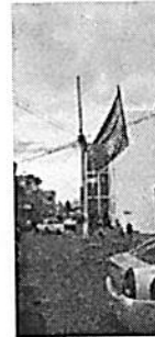
Poste 14m ECU 911 sin retirar.
