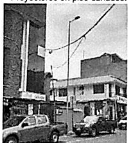
Poste sin Luminaria L99.
