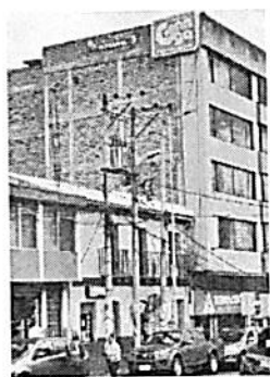
Red Aérea MV sin retirar Pe49
