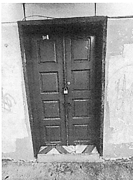
Imagen 8: Acabado Fachada. Fuente: Propia.
